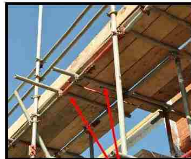
نمونه اجراء شده
