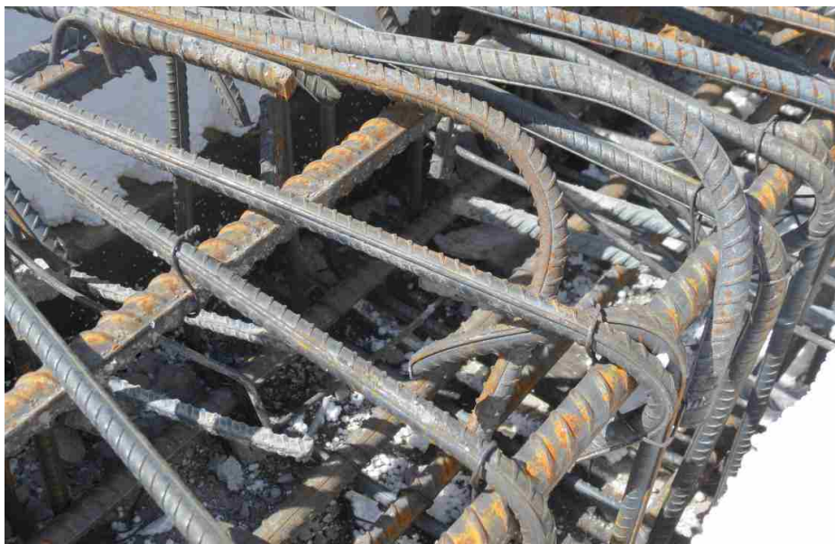
شکل ۱۵. قلاب نامناسب آرماتورهای تیر.
