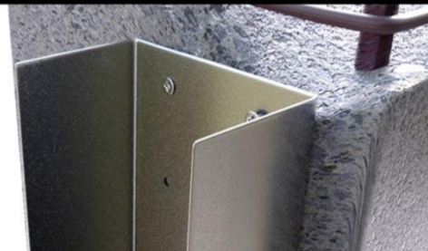
شکل ۵-۱ روش‌های اتصال دیوار به کلاف قائم بتنی
