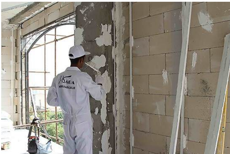
شکل ۱-۳۵- کرم‌بندی دیوارها
