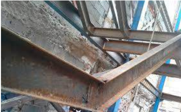
شکل ۱-۳۲- نصب تیرهای راه پله (شمشیری)
