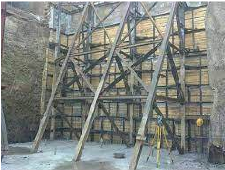
شکل ۱-۱-۱- مهار گود به روش خرپایی
