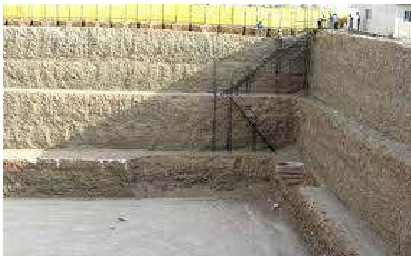
شکل ۱-۹- گودبرداری پله‌ای
