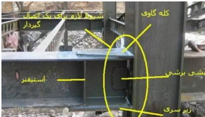
شکل ۳۱-۱- اتصال صلب تیر به ستون
