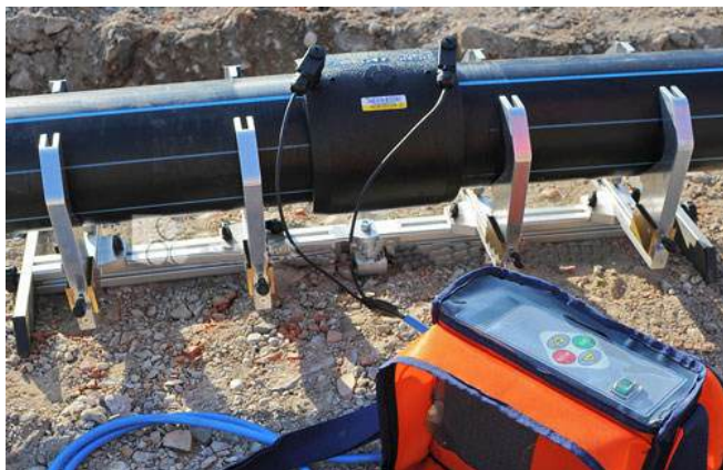
شکل ۲-۱- دستگاه جوش الکتروفیوژن
