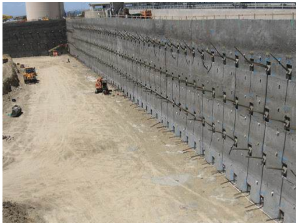
شکل ۱-۱۴- مهار دیواره‌های گود به روش دوخت به پشت
