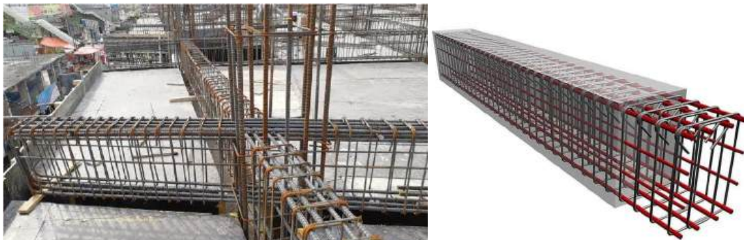
شکل ۲- تیر بتنی مسلح با میلگرد طولی و عرضی
