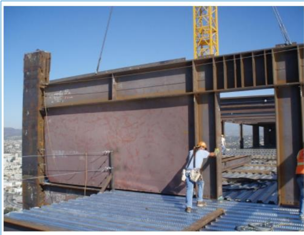
سیستم دیوار برشی فولادی
