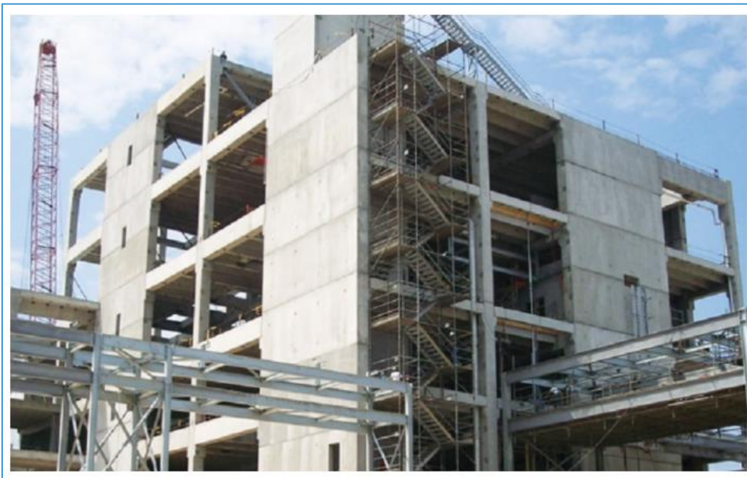
دیوار برشی بتنی یک سیستم باربر جانبی بتنی
