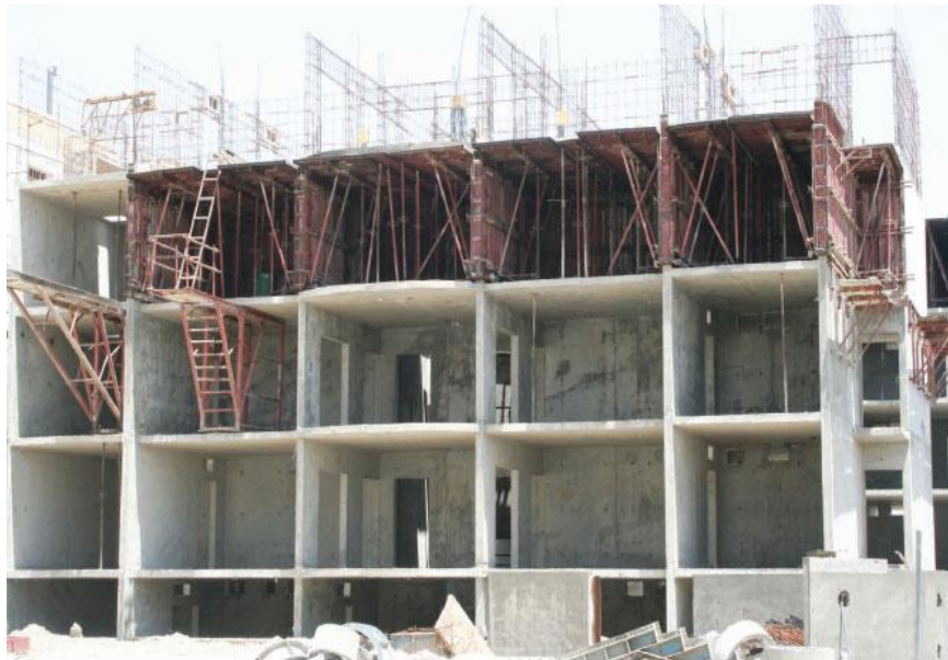
شکل ۳، سیستم دیوار باربر
