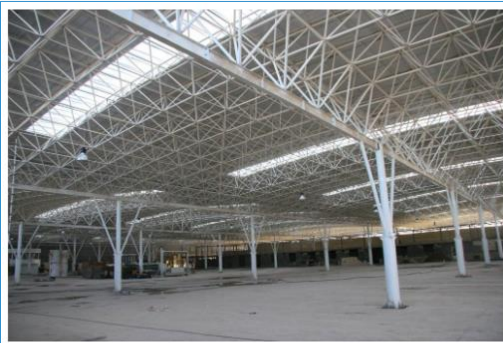
سیستم سقف سازه فضاکار با ستون‌های کنسولی
