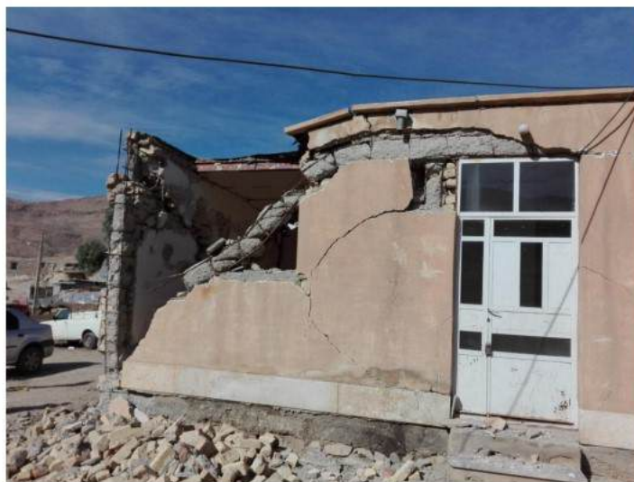
شکل (۶-۱۵): تابیدگی، شکستگی، صدمه دیدگی شدید در دیافراگم یک ساختمان مصالح بنایی
