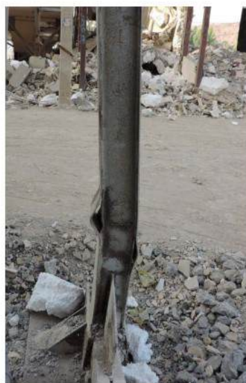
شکل (۴-۷): کماتش کلی ستون، کماتش موضعی، تشکیل مفصل پلاستیک
