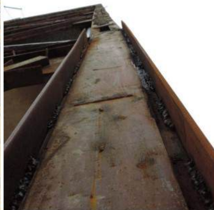
شکل (۳-۴): کج شدن و جابجایی ماندگار در سازه
