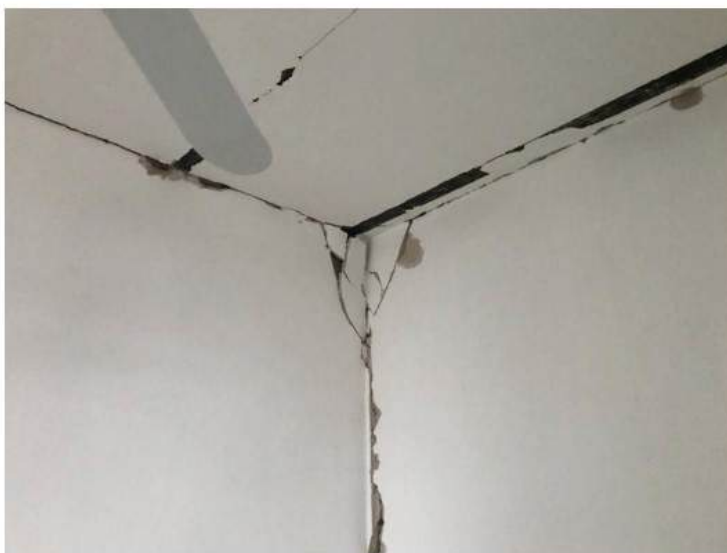
شکل (۶-۶): جداشدگی سقف از سیستم باربر جانبی در ساختمان مصالح بنایی
