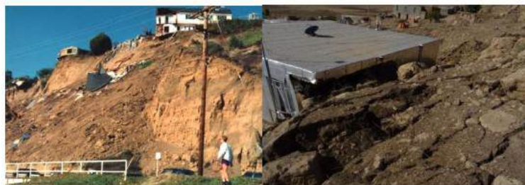
شکل (۷-۳): زمین‌لغزش و تخریب سازه‌های بالا و پایین‌دست شیروانی
