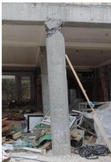
شکل (۹-۵): نمونه‌ای از آسیب ستون با شکل‌گیری مفصل پلاستیک در بخش فوقانی
