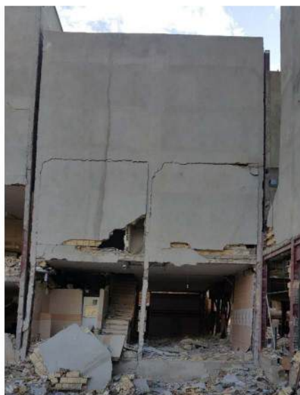
شکل (۴-۳۱): کج شدن محسوس ستون‌ها و دیوارها
