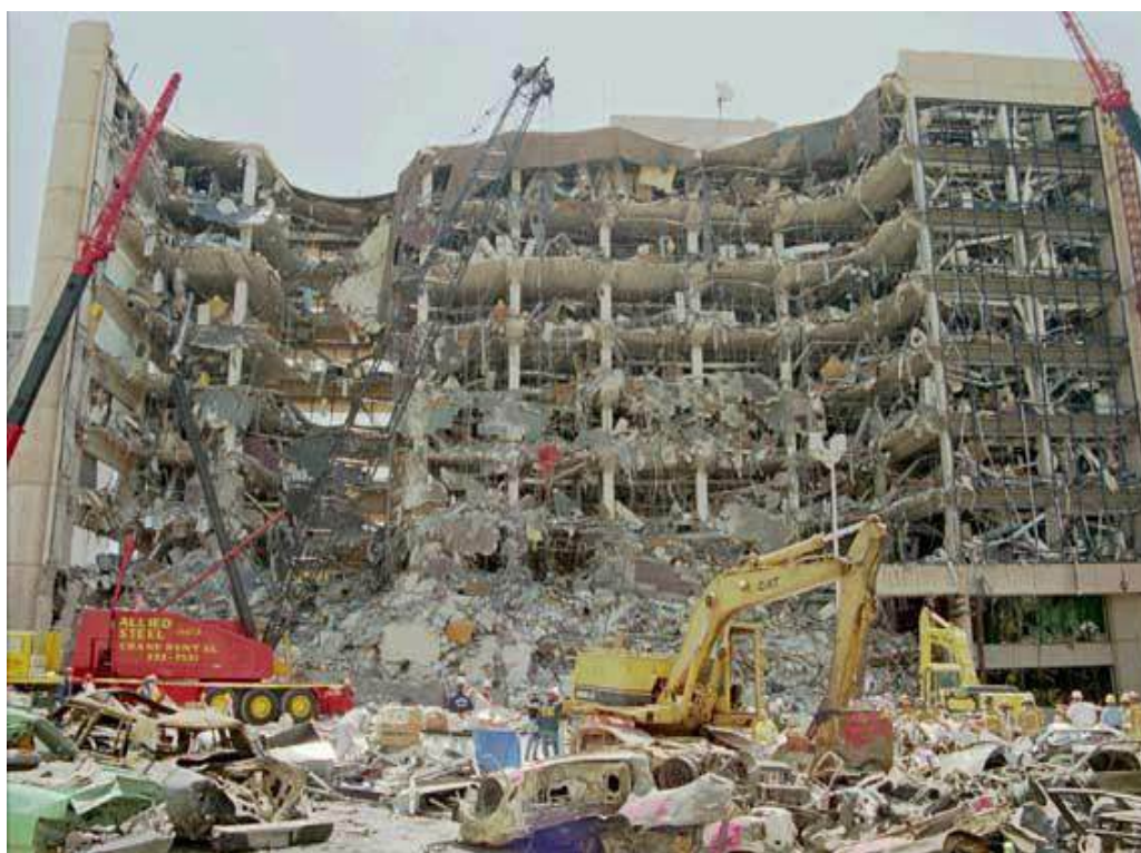
شکل ۳ خرابی پیشرونده در ساختمان فدرال مورا - media-3web.britannica.com/eb-media
