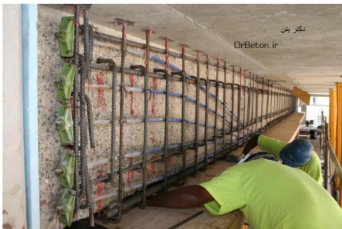
روش استفاده از پیش تنیدگی موضعی و ژاکت بتنی به صورت ترکیبی در مقاومسازی تیرهای بتنی
