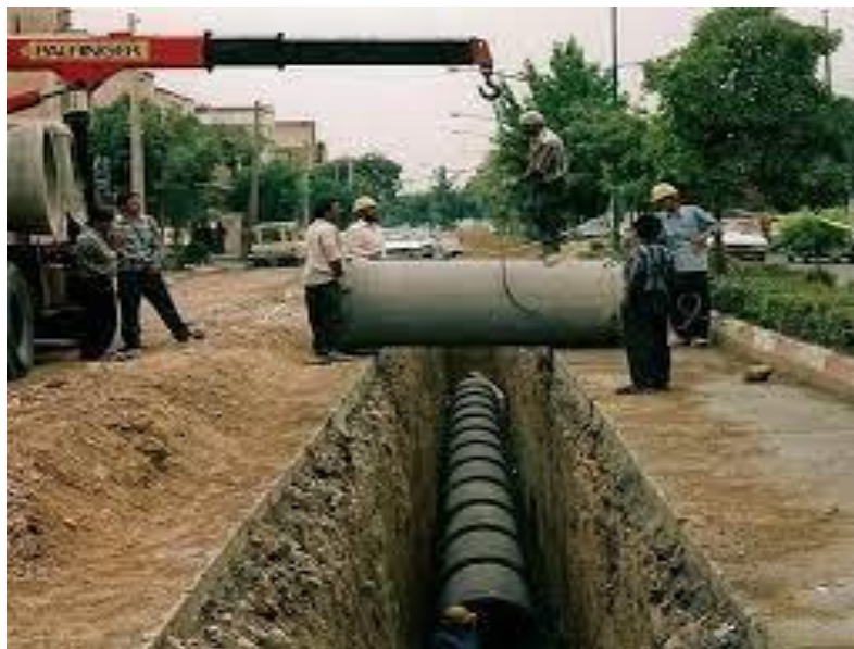
عملیات لوله گذاری بتنی
