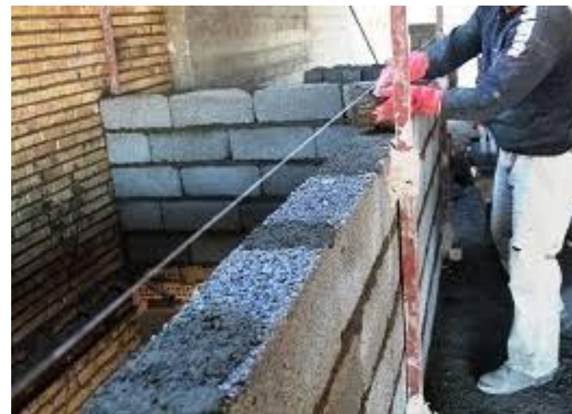
عملیات بلوک چینی سیمانی دیوار
