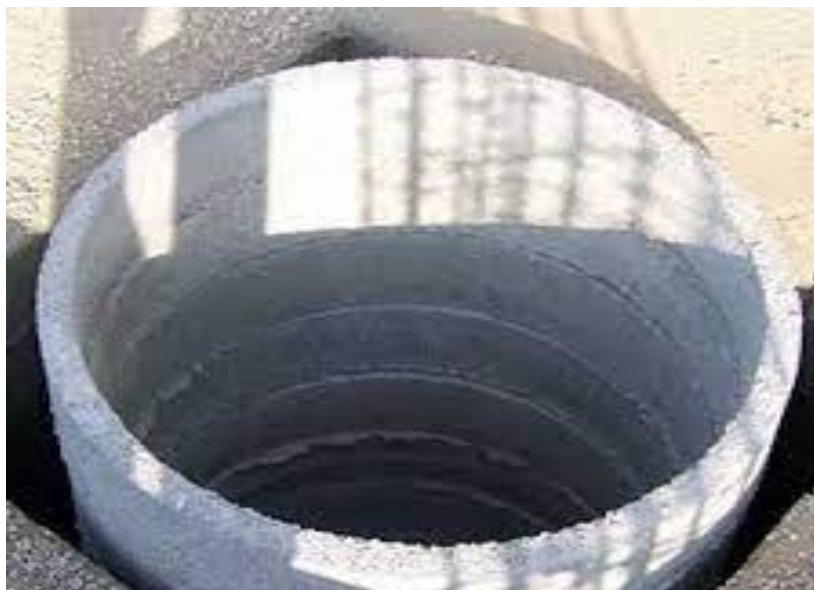
عملیات کول گذاری سیمانی میله چاه
