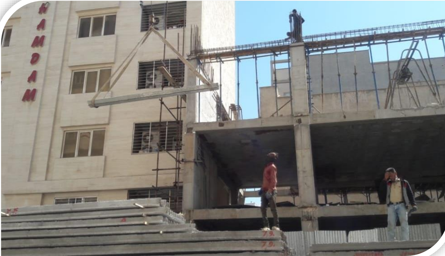
بالا بردن تیرچه توسط جرثقیل همزمان با تحویل بار
