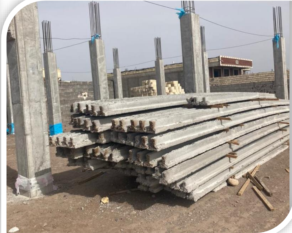
تخلیه تیرچه توسط جرثقیل محل پروژه
