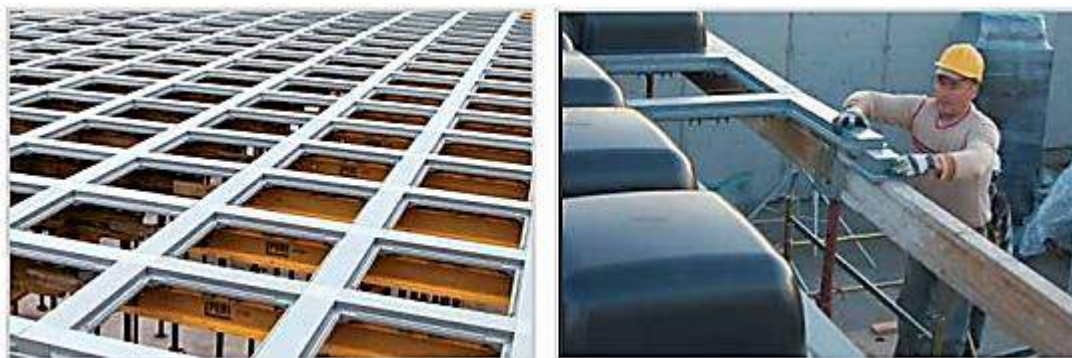
شکل ۸. قالب بندی و کفراژ بندی
