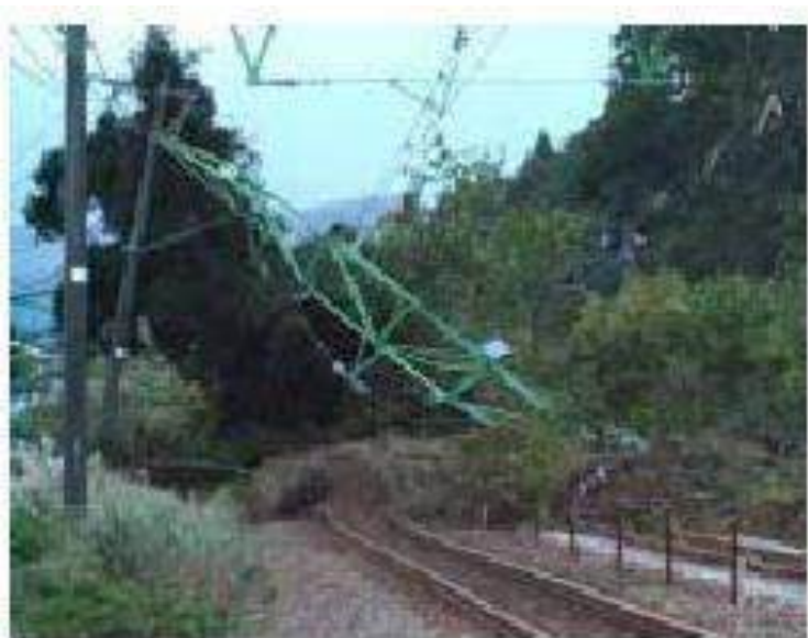
شکل 7- کمانش خط آهن و خرابی شبکه بالاسری در زلزله نیگاتای ژاپن
