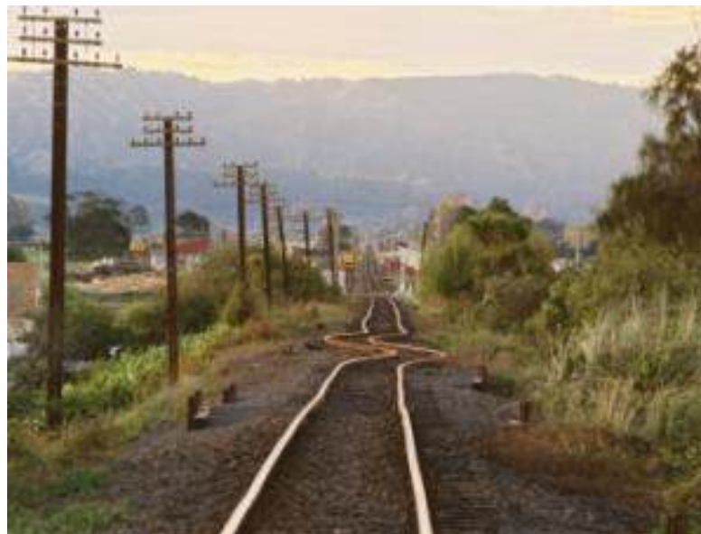
شکل 7- کمانش خط آهن و خرابی شبکه بالاسری در زلزله نیگاتای ژاپن
