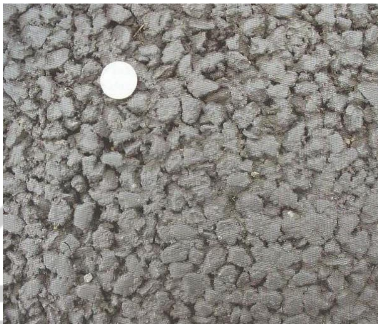
شکل 3: یک رویه نازک با سایز ۰/۱۴ (سکه یک یورو به قطر ۲۳ میلی‌متر است)
