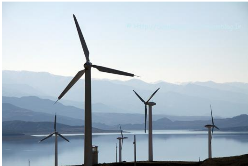
شکل (۲-۳): استفاده از نیروی باد در تولید برق
