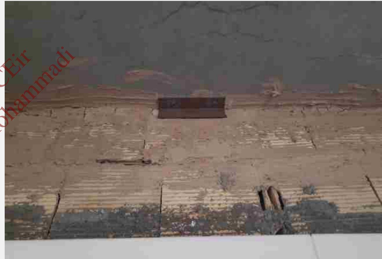
سطح بارگیر لبه فوقانی دیوار و طراحی نبشی در اتصال جداکننده دیوار به سقف
