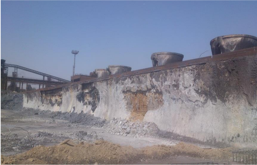
شکل ۱، دیواره حوضچه‌های تخلیه سرباره شرکت فولاد مبارکه
