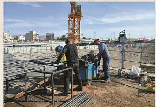
رزوه‌زنی میلگرد با روش رولینگ
