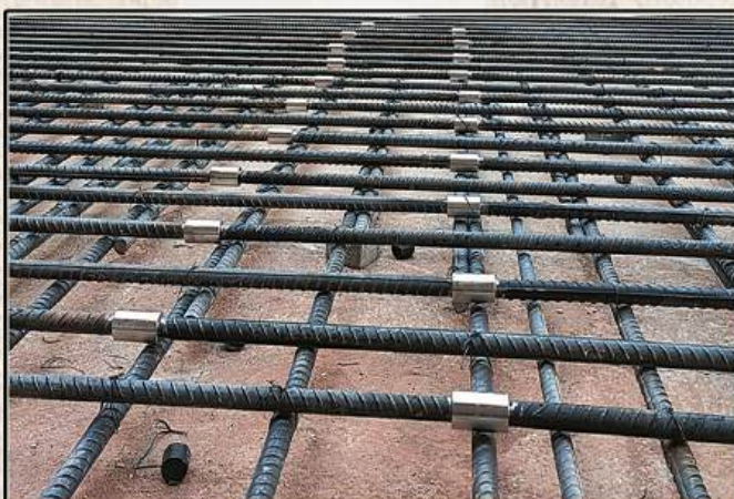
وصله مکانیکی در شبکه پایینی فونداسیون
