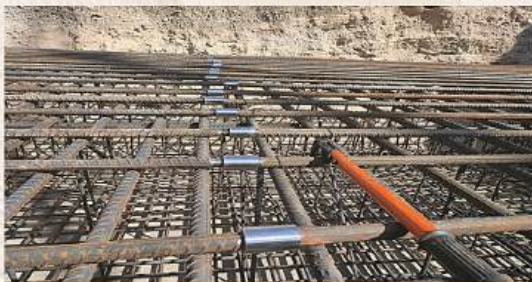
آچار مخصوص بستن کوپلرهای آرماتوربندی
