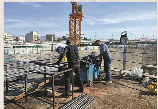
رزوه‌زنی میلگرد با روش رولینگ
