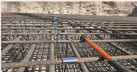
آچار مخصوص بستن کوپلرهای آرماتوربندی
