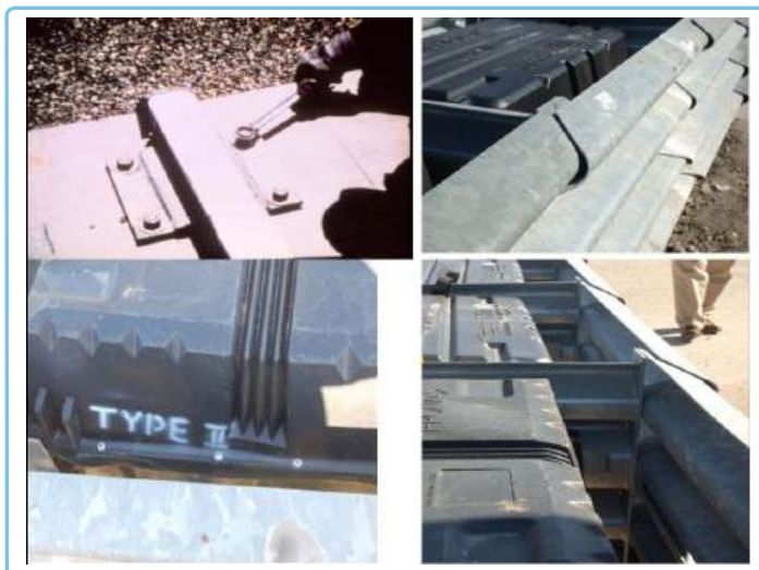
شکل ۱۶- جزئیات ضربه گیر Quadguard
