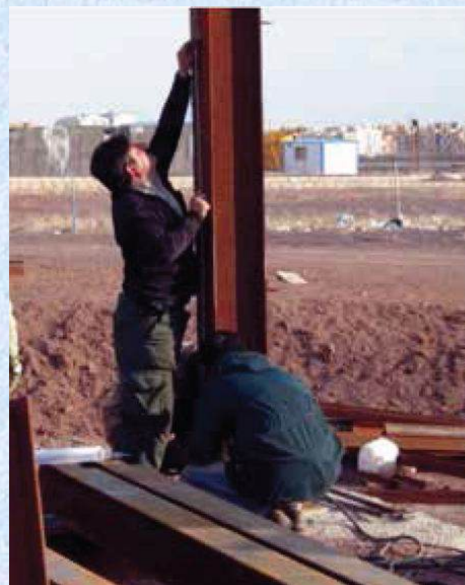
تنظیم پای ستون نسبت به خط محور و شاقولی کردن آن
