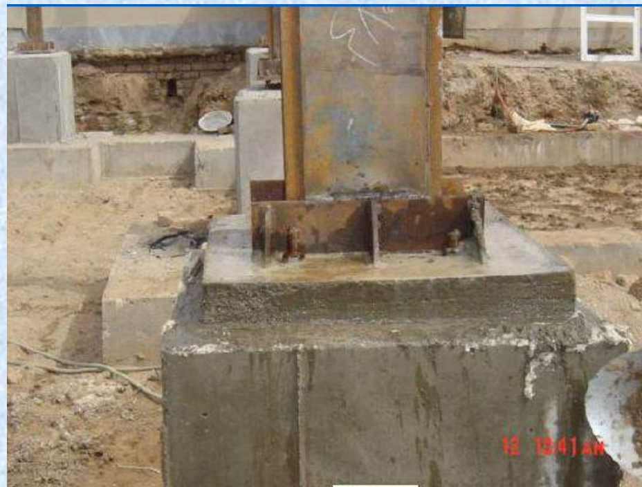
۷) برداشتن قالب پس از چند ساعت
