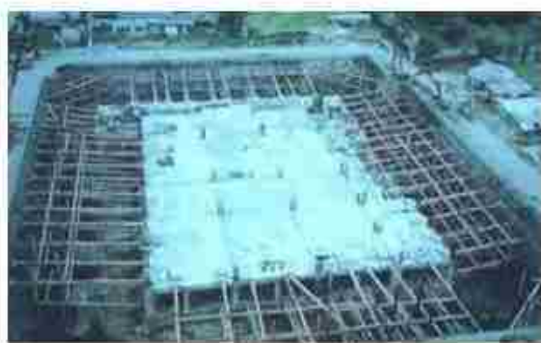
شکل ۴-۱۹- گودبرداری به روش ساخت جزیره‌ای
