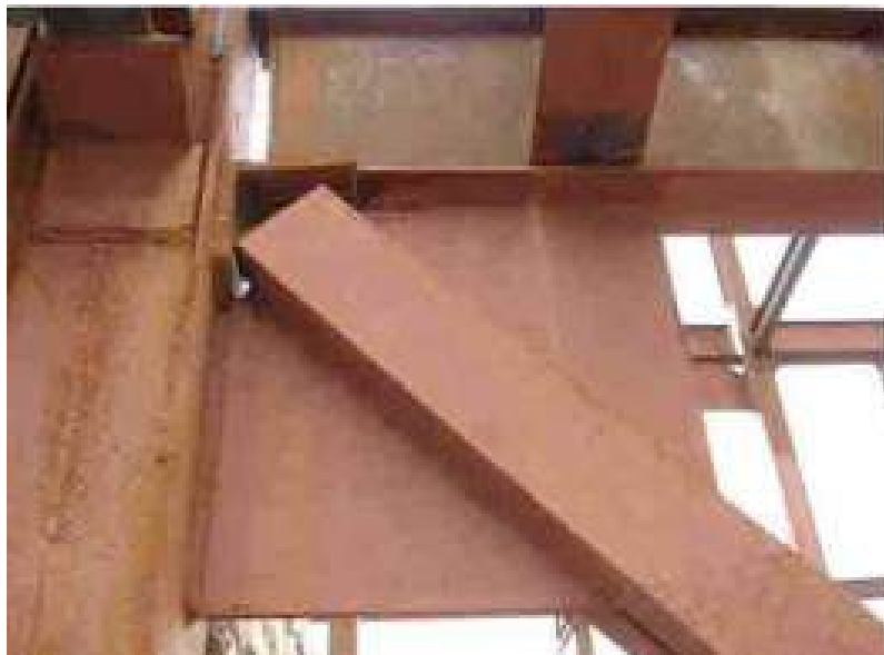
شکل (۴-۹) اتصال مهاربندی با ایجاد خط آزاد خمش
