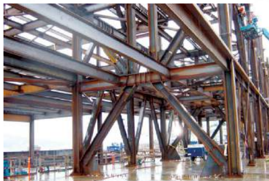
انواع قابهای مهاربندی برون محور (واگرا) EBF
