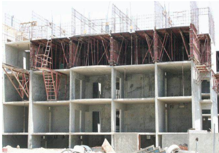
سیستم دیوارهای باربر
