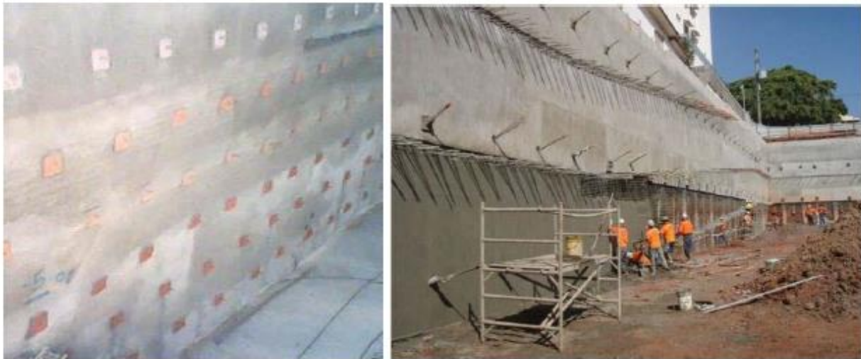
شکل (۱) – نمونه‌هایی از نیلینگ
