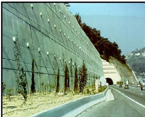
شکل (۳) – کاربرد نیلینگ در پروژه‌ها
