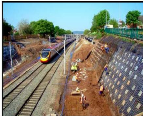
شکل (۳) – کاربرد نیلینگ در پروژه‌ها
