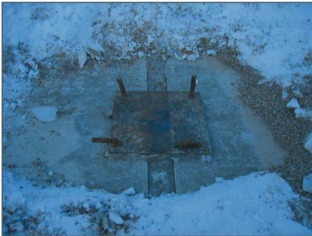
شکل ۲-۷، خم شدن میل مهارها در اثر عبور جرثقیل روی آن.
