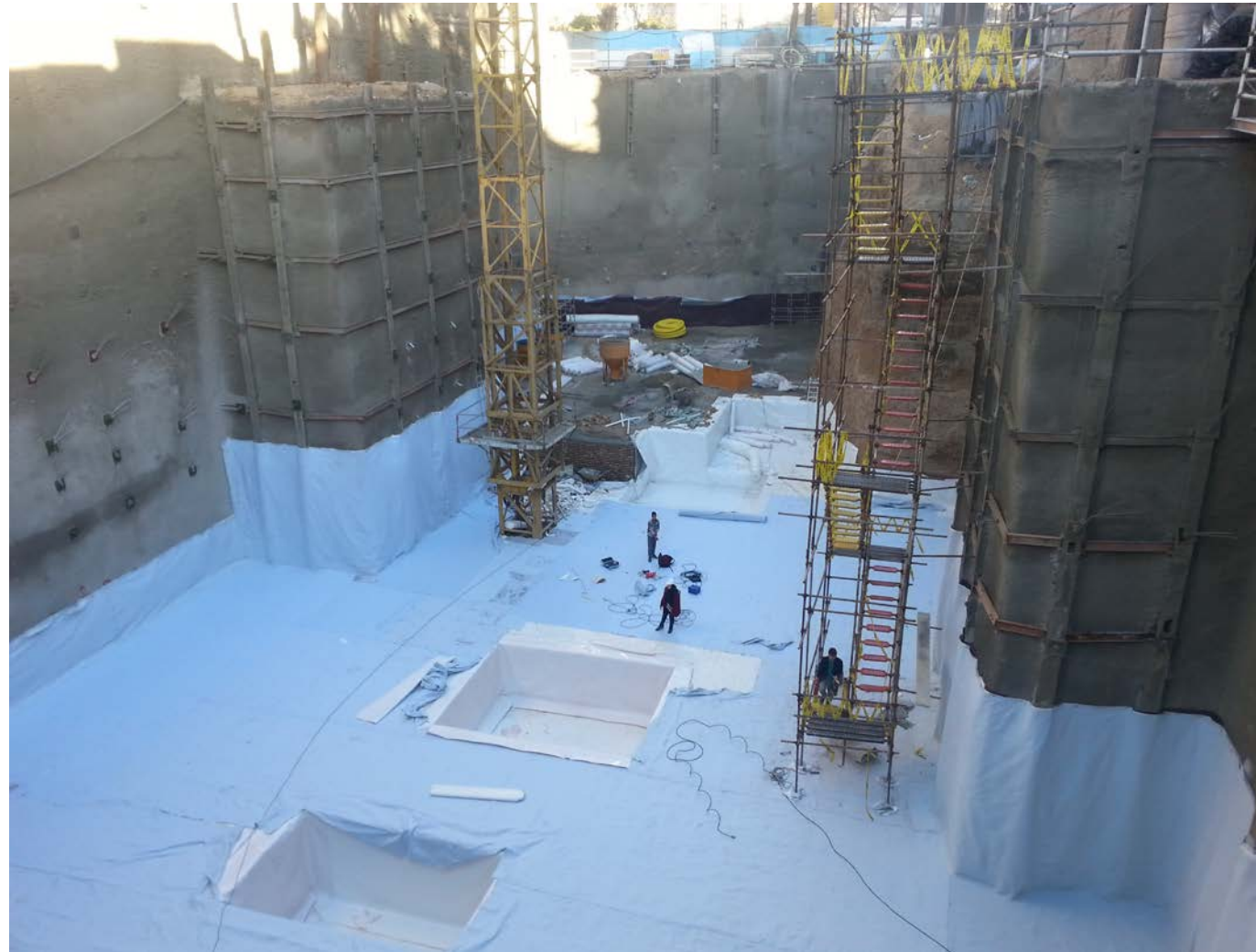
پروژه ای در منطقه دروس تهران
