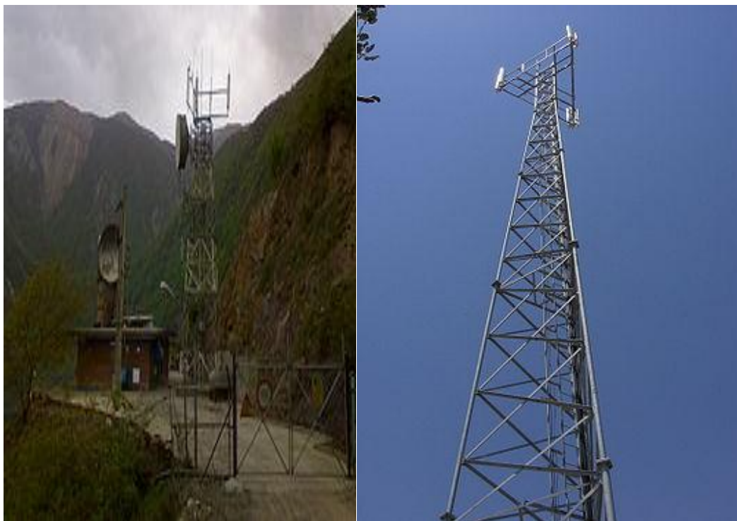
شکل شماره ۳: دکل ۳۰ متری ۳ پایه، دکل ۴ پایه خود ایستا، ماخذ: سایت مخابرات
