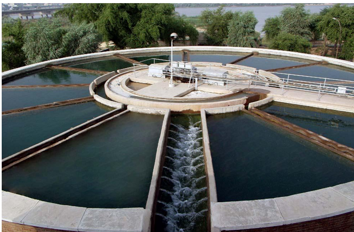
تصفیه خانه قزوین
