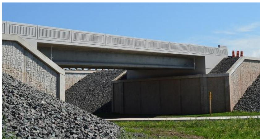
شکل (۲-۱۲): نمونه اجراء شده پل یکپارچه
