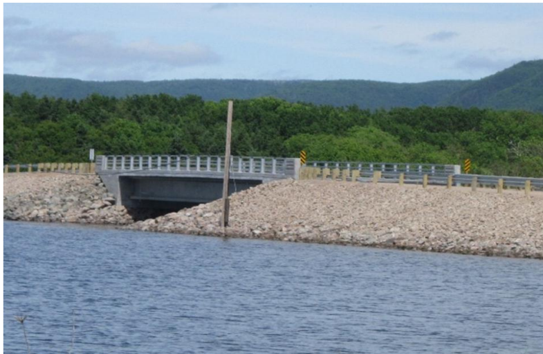
شکل (۷-۲): نمونه اجراء شده پل نیمه یکپارچه
