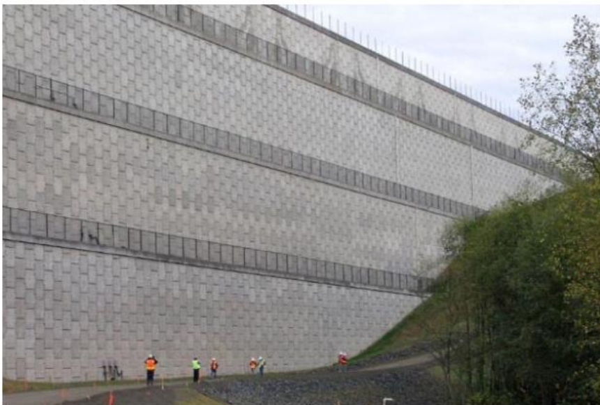
شکل (۱۲-۳)، دیوار خاک مسلح فرودگاه SeaTac در ایالت واشینگتن به ارتفاع حدود ۴۲ متر
