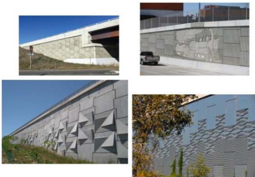
شکل (۳-۱۵)، انواع پانل های پیش ساخته بتنی
