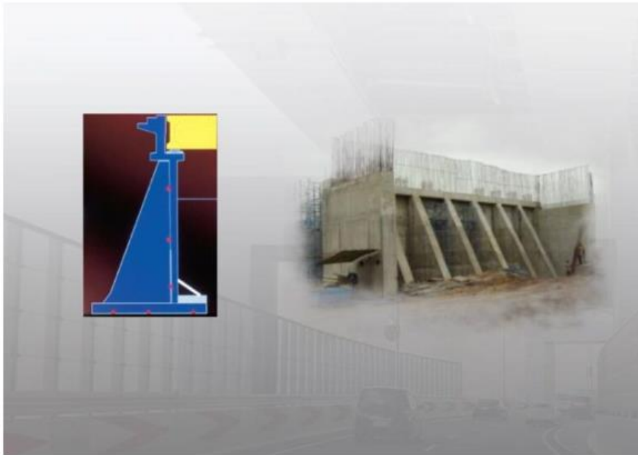
شکل (۳-۴)، کوله بسته با پشتبند
