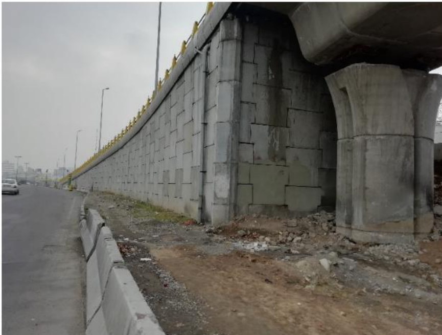
شکل (۱۱-۳)، کوله خاک مسلح در پل سگمنتی به روش طره متعادل
