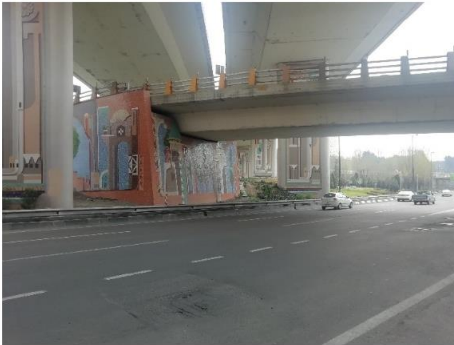
شکل (۳-۲)، کوله بسته بتن مسلح
