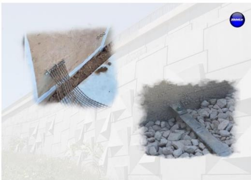
شکل (۳-۱۶)، نحوه اتصال مسلح کننده های پلیمری و تسمه فلزی به پانل های بتنی پیش ساخته
