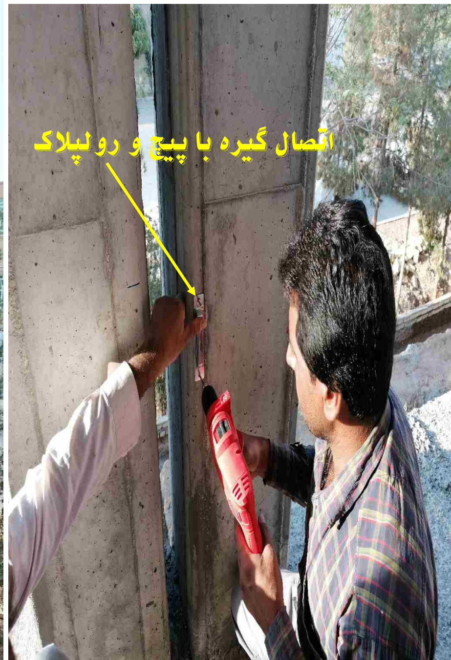
سوراخکاری در خارج از کاور بتنی
