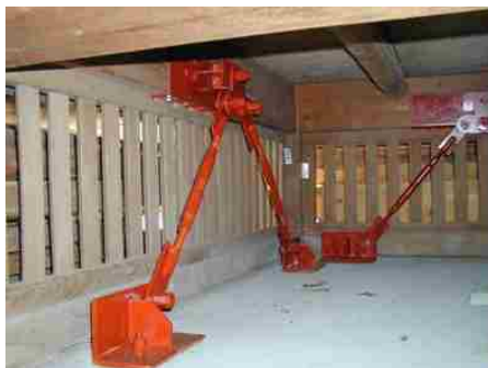
شکل ۷-۵ میراگر ویسکوالاستیک بکار رفته برای کنترل ارتعاش در سازه‌ای چوبی [۱۷].
