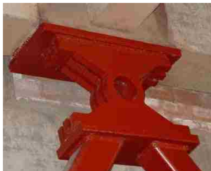
شکل ۷۰-۷ نحوه‌ی نصب میراگر RHMD در یک سازه‌ی ساختمانی [۵۲].
