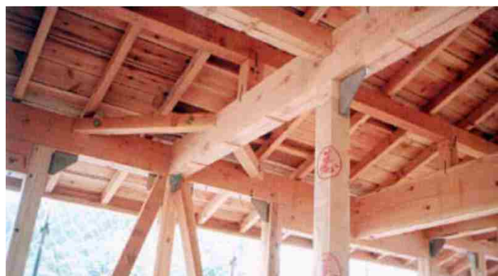
شکل ۵-۱۰ ساختمان چوبی مقاوم سازی شده با میراگرهای ویسکوالاستیک [۱۷].
