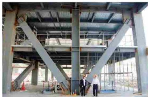
شکل ۳۶-۷ کاربرد مهاربندهای BRB طولیل در یکی از ساختمان های دولتی تایوان [۳۹].
