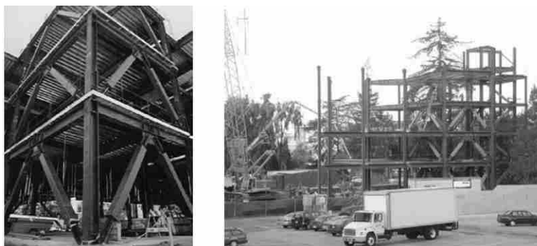
شکل ۲۰-۴ چینش شورن میراگرها در دانشگاه کالیفرنیا [۱۵].
