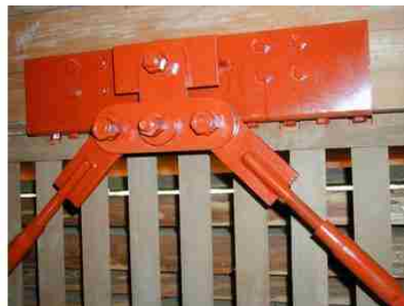
شکل ۷-۵ میراگر ویسکوالاستیک بکار رفته برای کنترل ارتعاش در سازه‌ای چوبی [۱۷].
