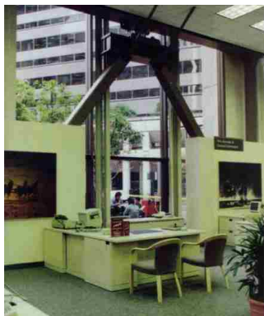
شکل ۷-۷۷ میراگرهای تسلیمی ADAS بکار رفته در سازه بانک ولز فارگو [۳].
