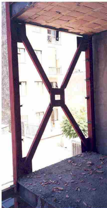
میراگرهای واقع شده در سازه
