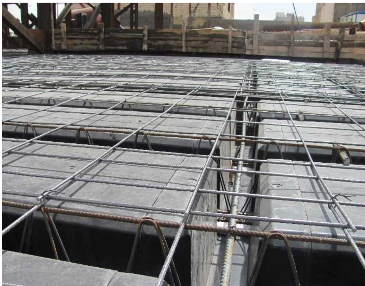
اجرای تیرچه درجا با استفاده از خرپای آماده
