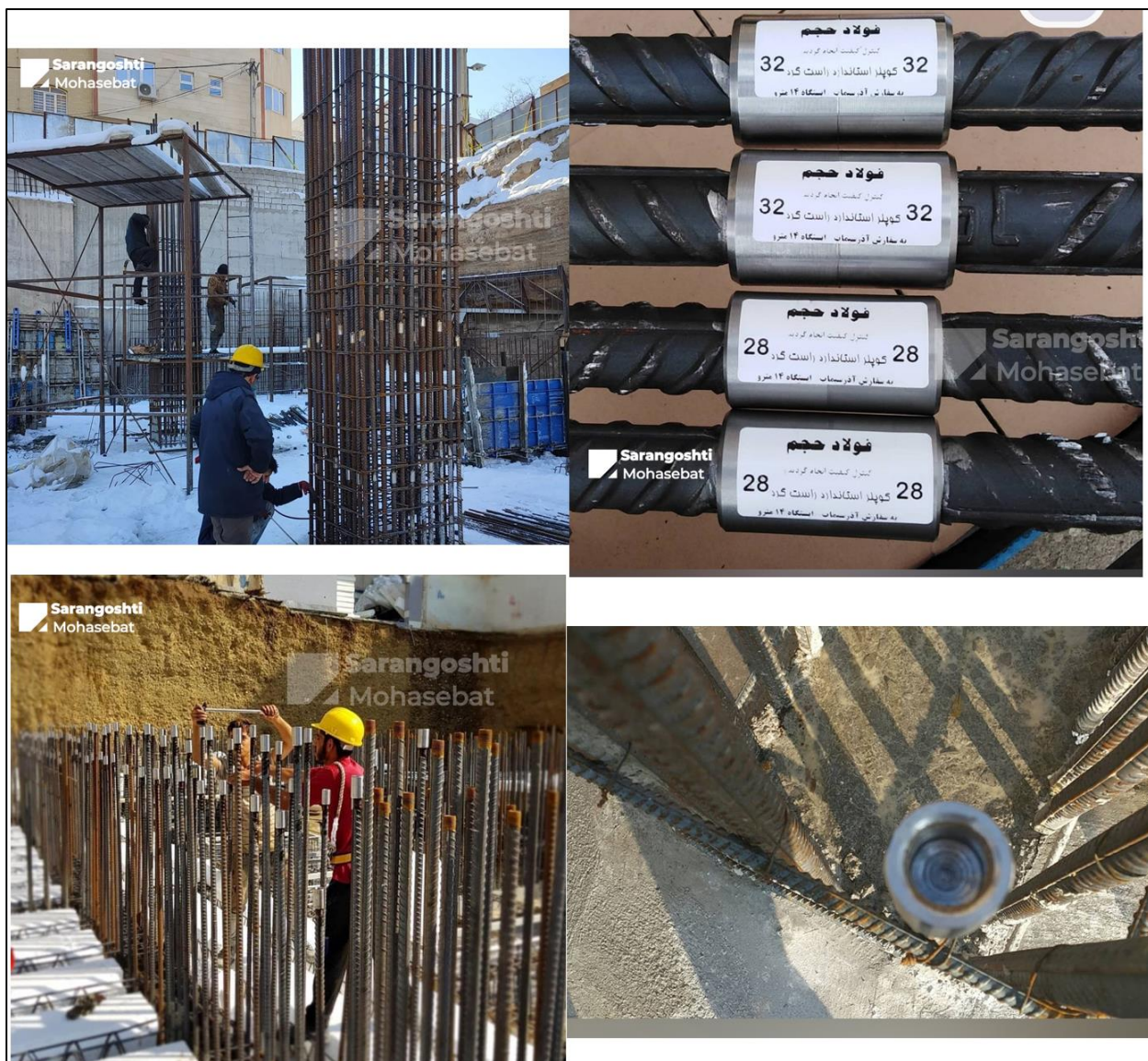
تصاویری از اجرای وصله مکانیکی (کوپلینگ)
