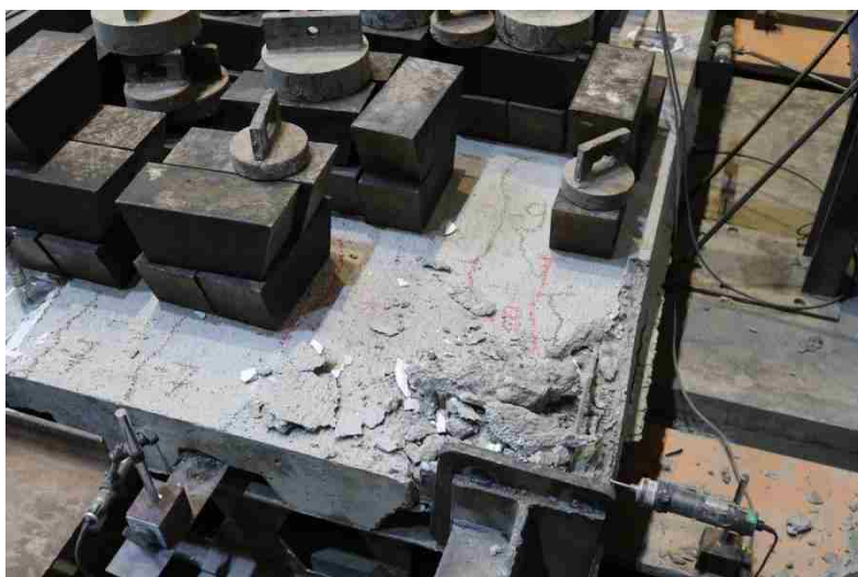
شکل شماره ۵-۶۶ - تخریب دال در نمونه سوم
