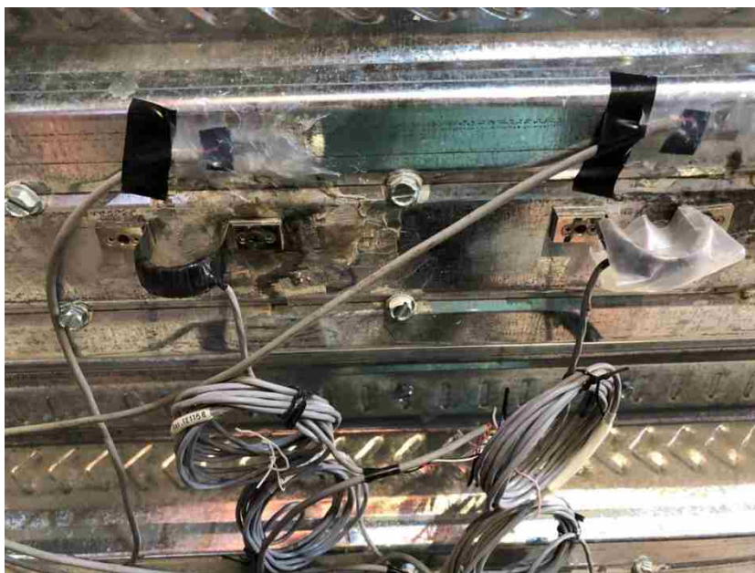
شکل ۳-۱۸- نصب جابجایی‌سنج‌ها با چسب مخصوص و تعبیه رول‌پلاک در داخل بتن جهت نصب یک
