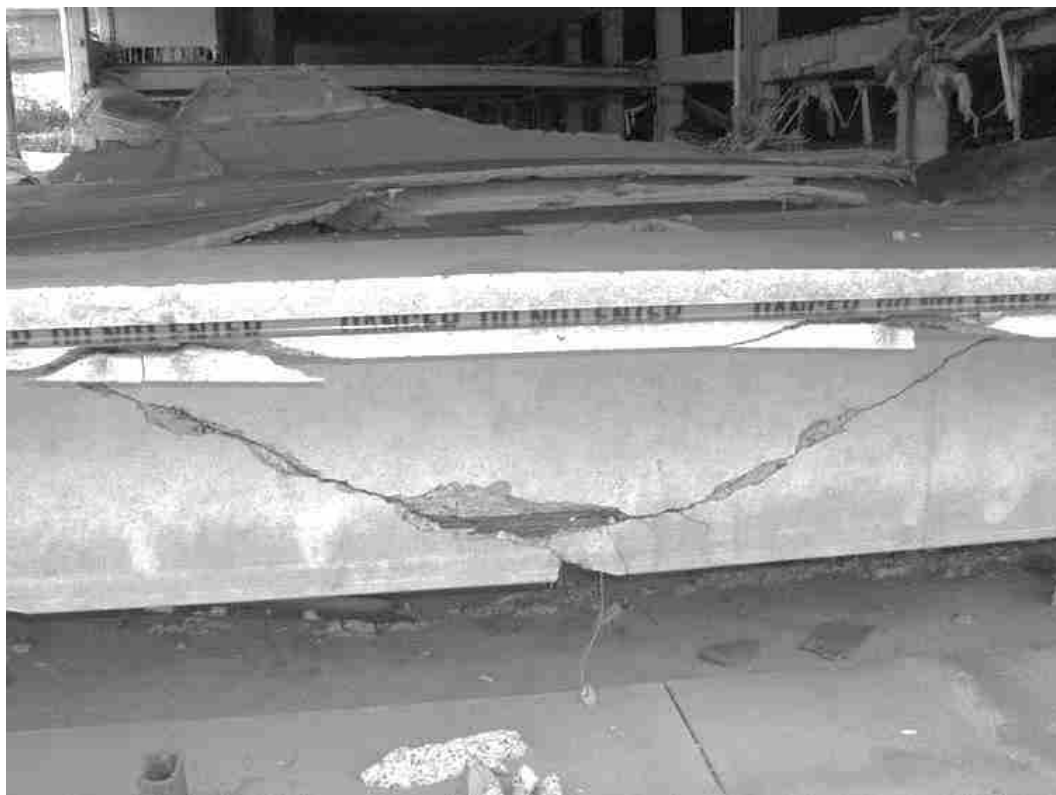
انتقال برش از طريق كشش قطرى
