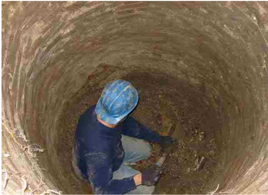
تصویر شماره ۵- حفاری چاه اعضای قائم
