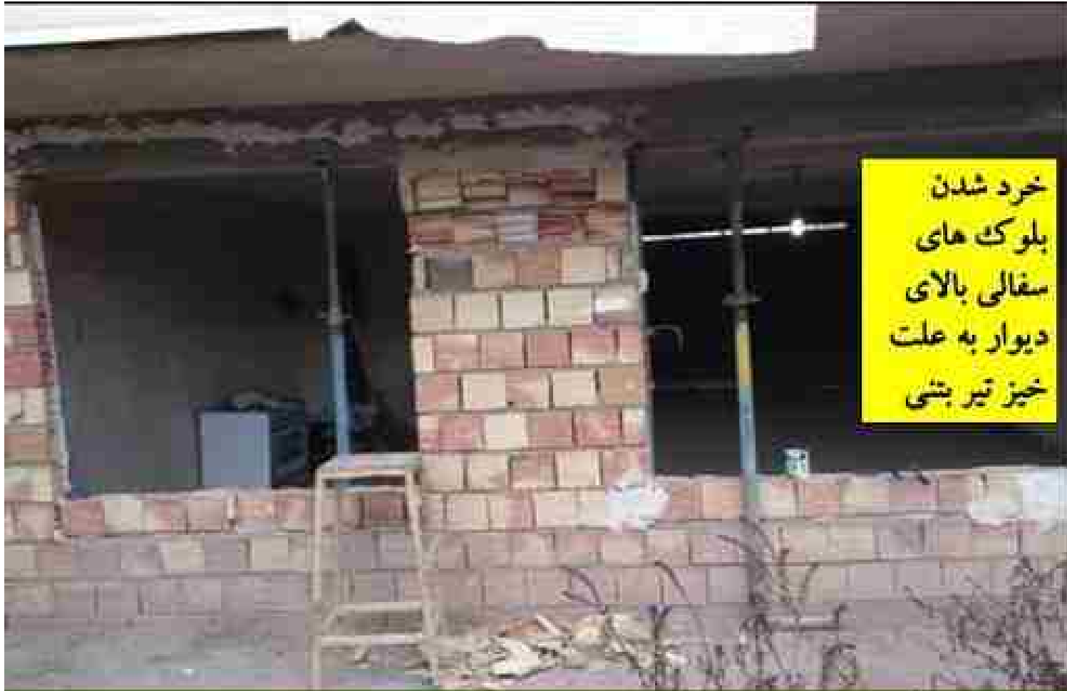
این عکس ها مربوط به یک ساختمان بتن آرمه می باشد که بعد از ۳ سال تیر بغل بالکن به دهانه حدود ۶ متر و به ابعاد ۴۵ در ۴۰ سانتی متر خیز پیدا کرده است.
