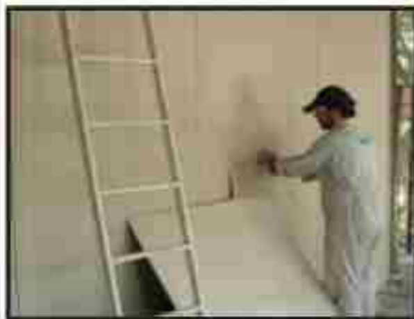
نصب گچ برگ در دیوارهای داخلی
