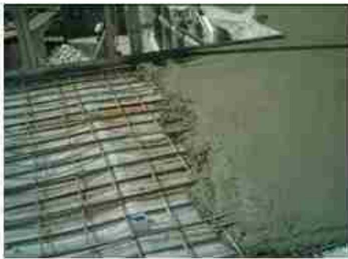
بتن ریزی سقف
