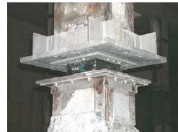
شکل ۱۳- جداگر لرزه ای یا ایزولاتور
