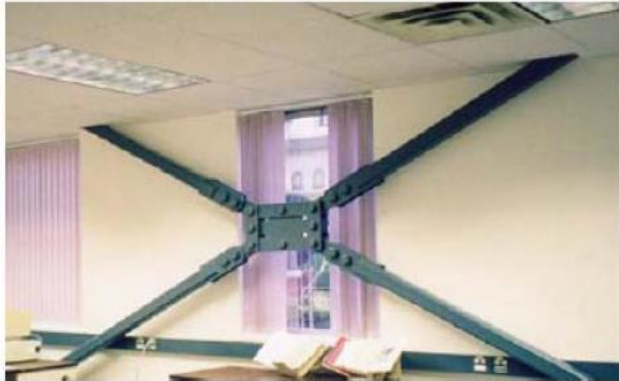
شکل ۱۴- میراگر اصطکاکی پال
